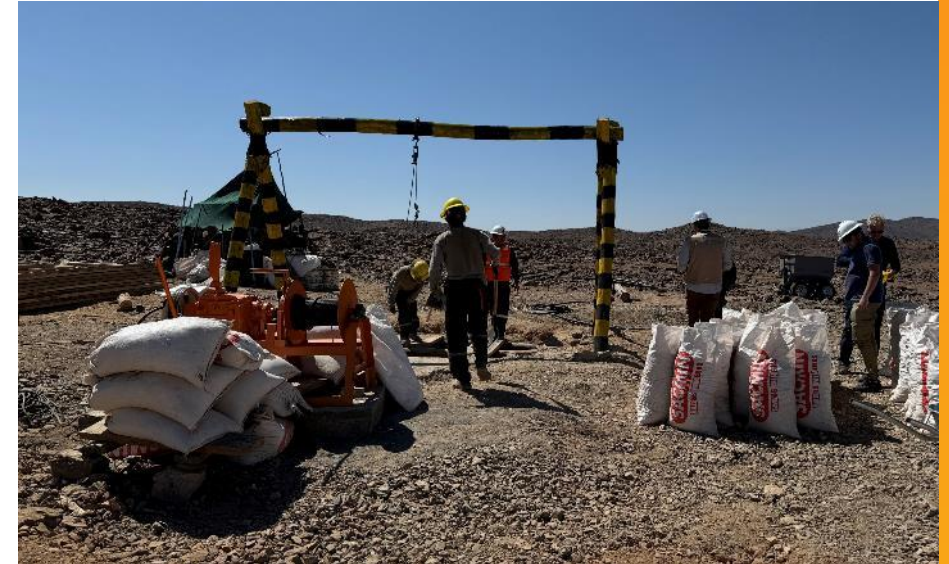
“Bonanza” mine shaft (Aug-24)
